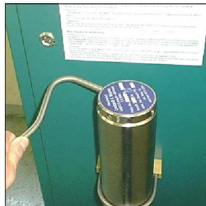
Abb. 1 - Abschrauben des Filtergehäuse-Deckels
