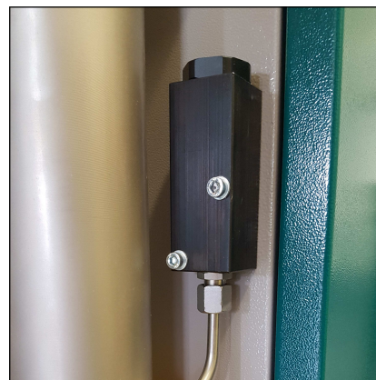
Druckhalte- / Rückschlagventil
