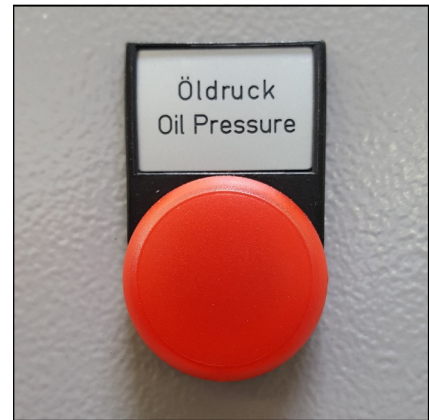
Öldrucküberwachung
